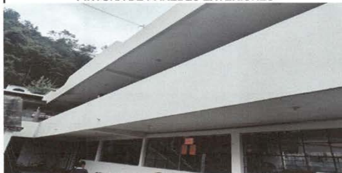
Foto 3: edificio pintado en sus paredes exteriores
