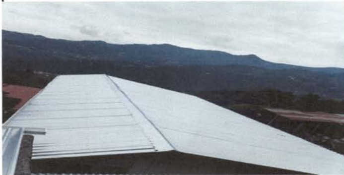
Foto 2: Lamina troquelada calibre 26 instalada, Modulo No. 2. con su respectivo capote
