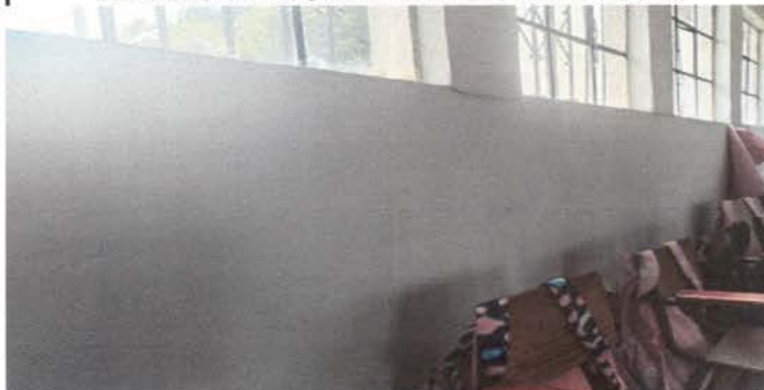
Foto 4: Repello realizado y pared interior pintado
