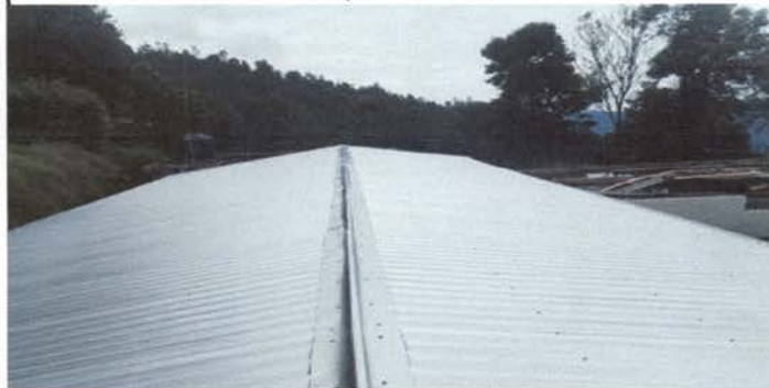
Foto1: Lamina troquelada calibre 26 instalada, Modulo No. 1, Con su respectivo capote.
