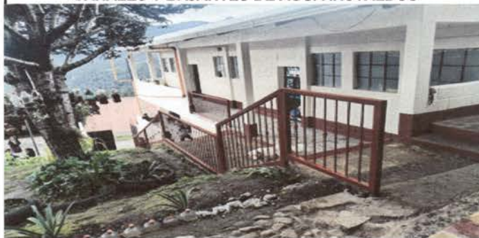
Foto 6: Canales PVC instalados ademas de sus bajantes de agua de 3"
